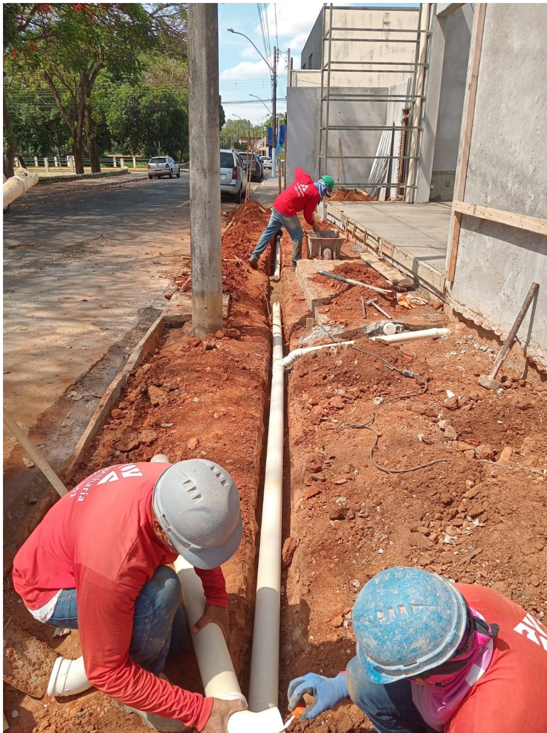
Mudança da rede de esgoto para calçada
