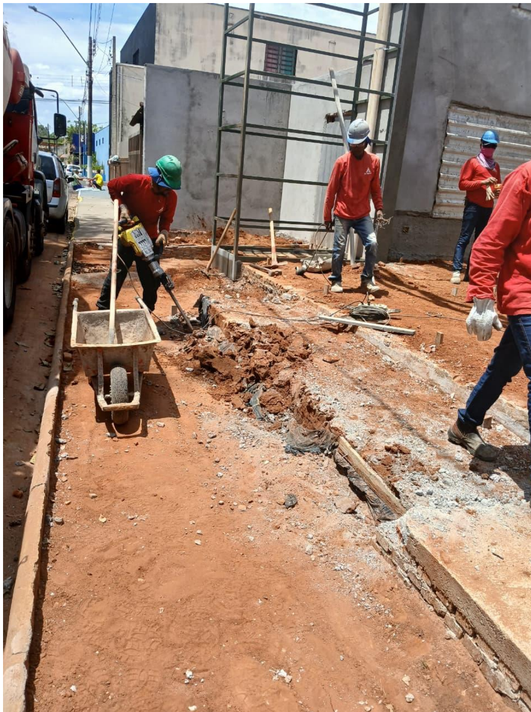
Demolição da rampa, muretas e calçada com marteleiro rompedor
