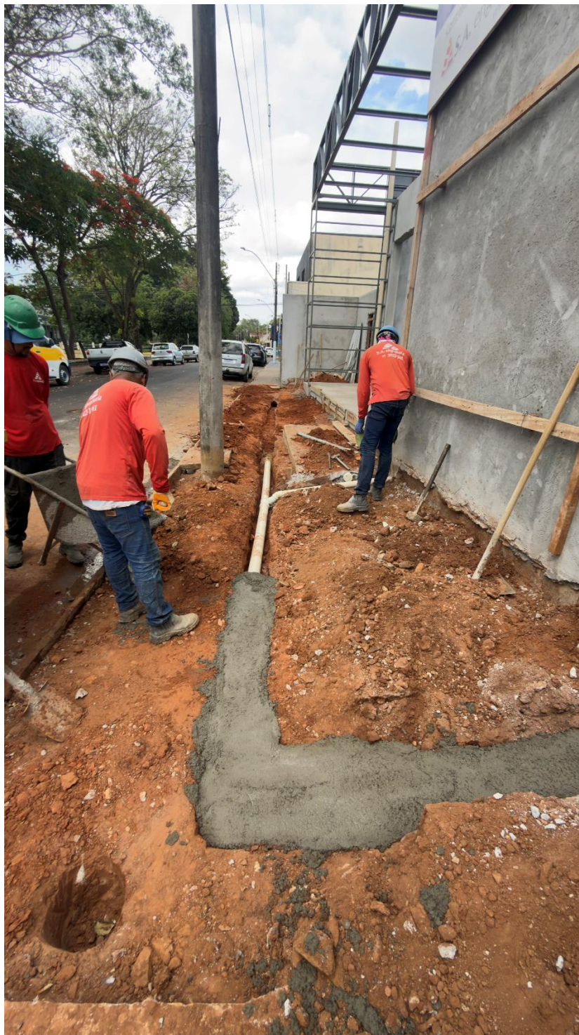
Envolvimento da tubulação de esgoto com concreto
