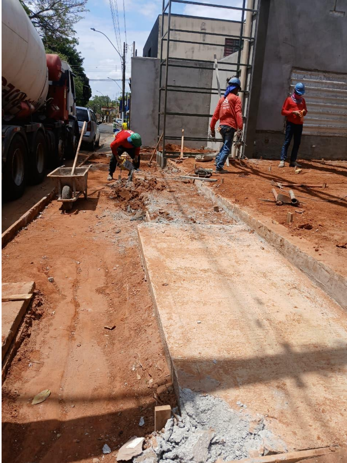
Demolição da rampa, muretas e calçada com martelete rompedor
