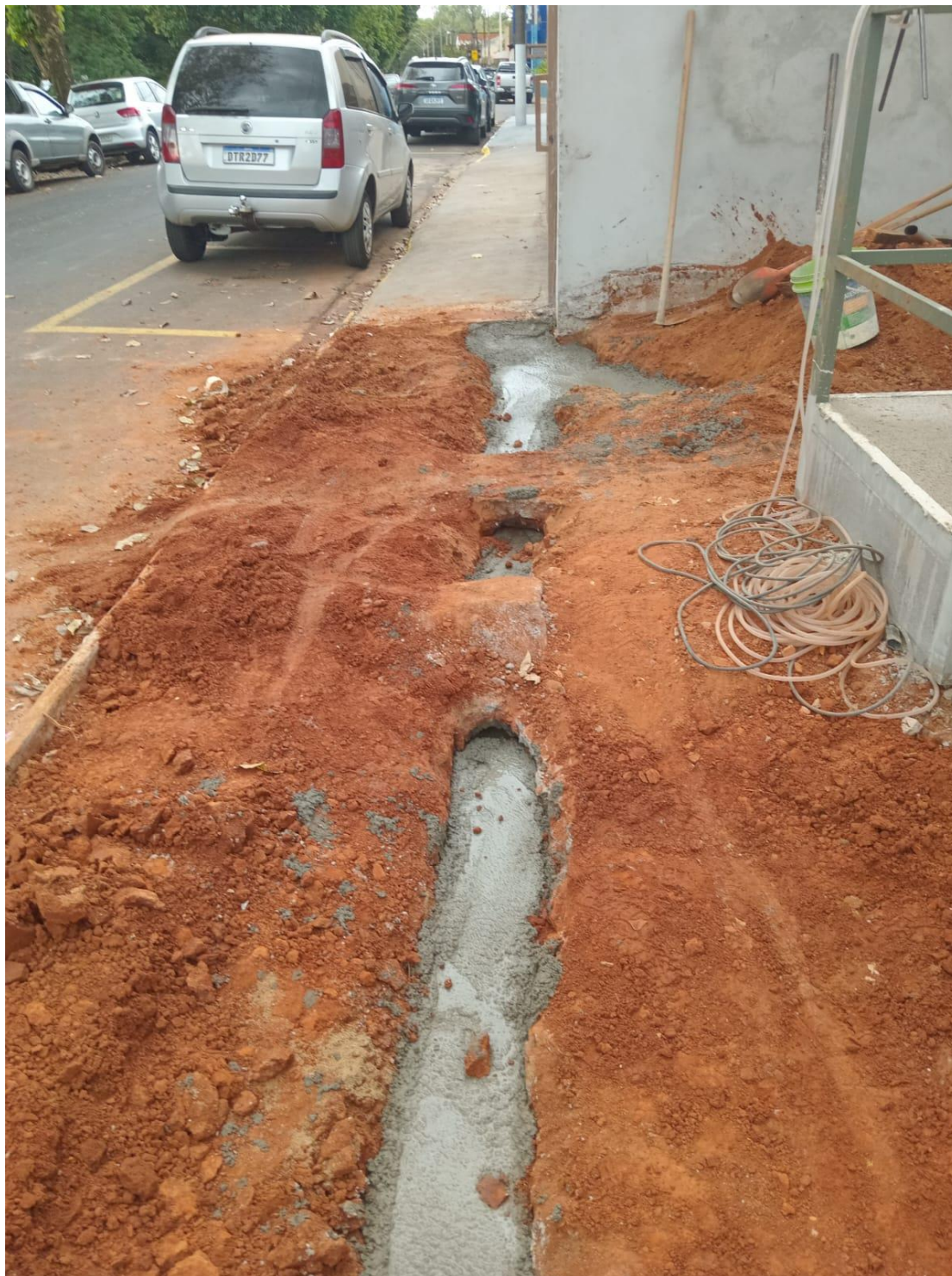
Envelopamento da tubulação de esgoto com concreto
